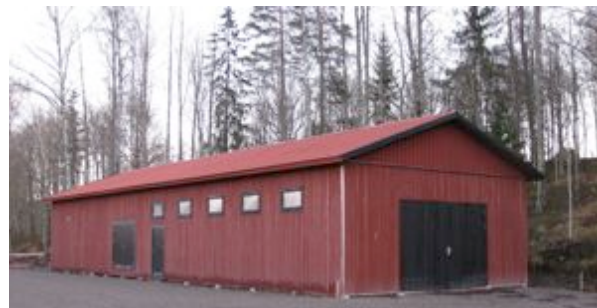
Efter dräneringsarbeten och gjutning av golv så går det äntligen att använda den nya logen.
