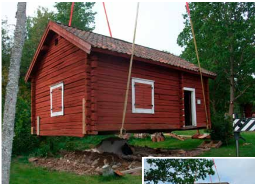
Soldatstugan lyftes med kran för flyttning. Innan hade stugan tömts på inventarier och den utdömda murstocken plockats ned. Foto: Ola Wikström.
