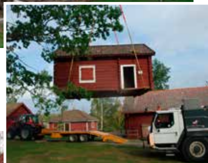
Soldatstugan lyftes med kran för flyttning. Innan hade stugan tömts på inventarier och den utdömda murstocken plockats ned. Foto: Ola Wikström.
