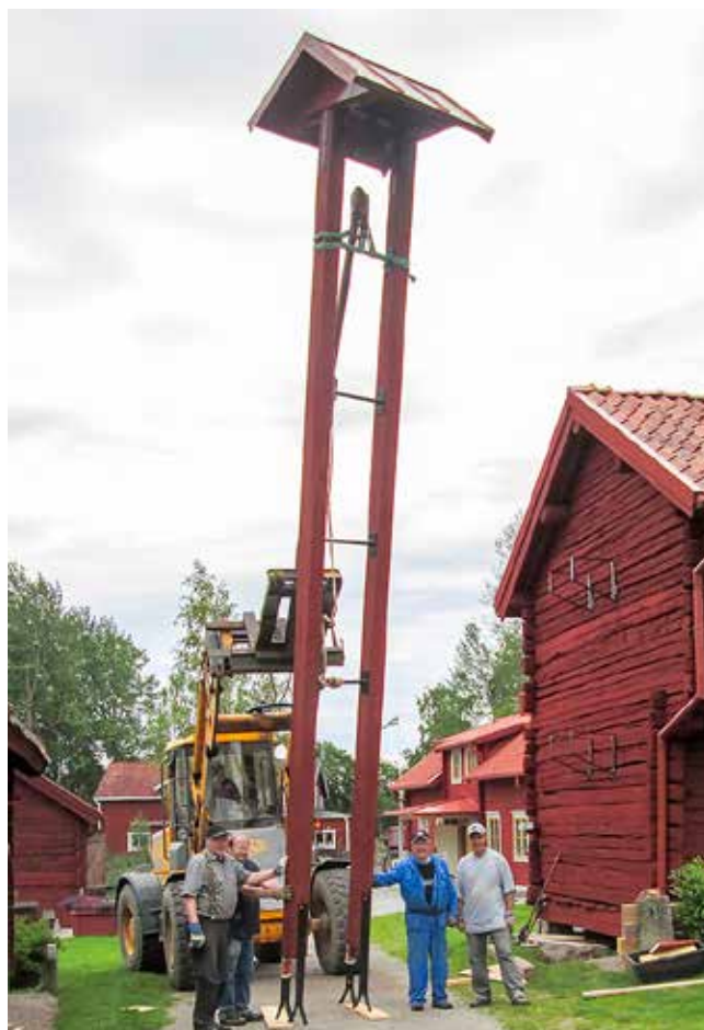
Klockstapeln lyfts på plats. Lastmaskin från Prästgården med Conny Aldén som maskinförare. Foto: Anders Fläcke.
